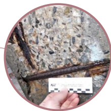
Modernizovaný úsek 16, dálniční nadjezd EXIT 119 Velký Beranov ev. č. DN1-161.1
