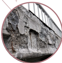
Modernizovaný úsek 02, dálniční most EXIT 21 Mirošovice ev. č. D1-30..1
